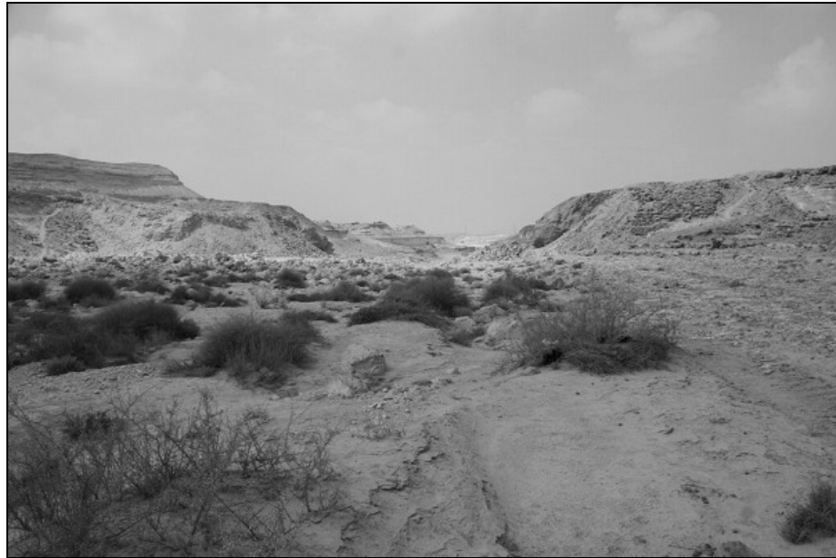
Obrázek 80 Trosky starověké přehrady Kafara u Káhiry. Přehrada byly zbudovány někdy mezi lety 2650–2465 př. Kr. Hráz byla 14 m vysoká, přes 113 m dlouhá a vzdouvala množství vody o objemu 0,5 mil. m 3 . Přehrada se brzy po svém dokončení protrhla, v důsledku nenadálého přívalu vody a již nebyla obnovena. (foto: J. L. Frerotte)
