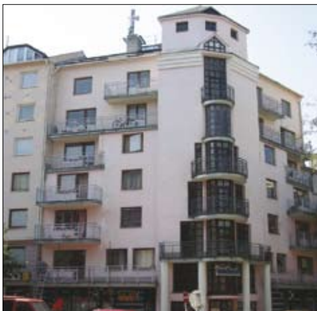
Foto 5: Dostavba proluky ve vnitřním městě (zóna B, I. vývojová etapa)
