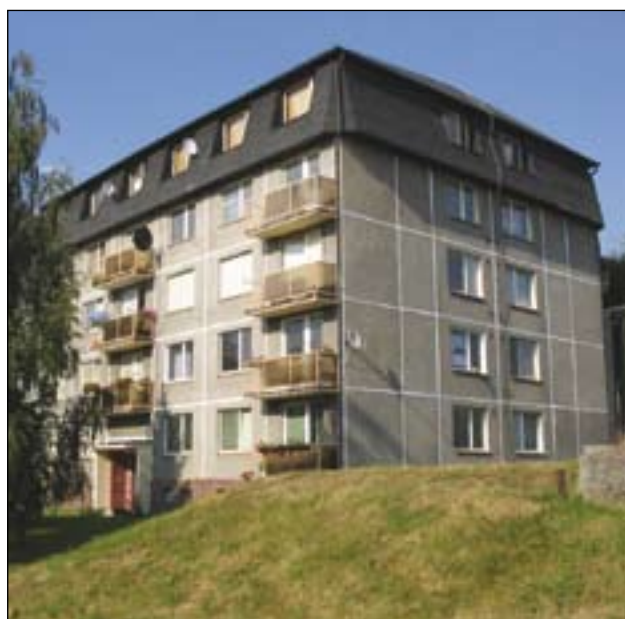
Foto 4: Nástavby bytů na stávající budovy (zóna D, I., II. vývojová etapa)
