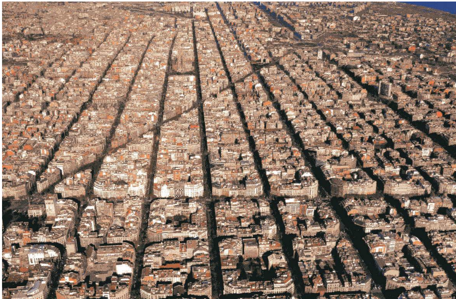
Barcelona a známá ulice Diagonal (architekt Cerda)
