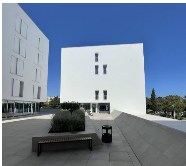
Nová moderní budova univerzitního kampusu (archiv autora)
